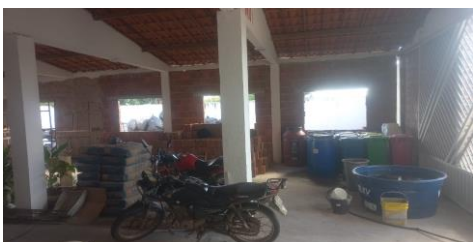
VERGA RETA DE CONCRETO ARMADO
