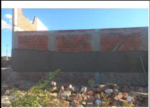
MURO CONTORNO DE ALVENARIA E CONCRETO (PILAR+CINTA) REBOCADO, COM PINTURA
