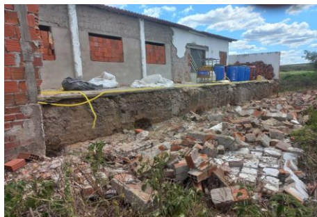
DEMOLIÇÃO DE ALVENARIA DE TIJOLOS S/ REAPROVEITAMENTO
