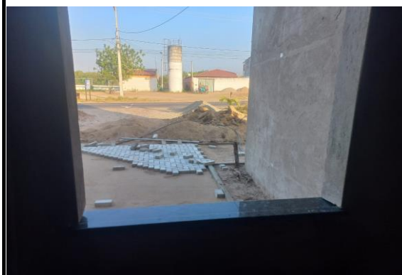
PISO INTERTRAVADO TIPO TIJOLINHO (20X10X10)CM 35MPA, COR CINZA - COMPACTAÇÃO MECANIZADA
