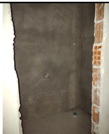
PONTO HIDRÁULICO, MATERIAL E EXECUÇÃO
