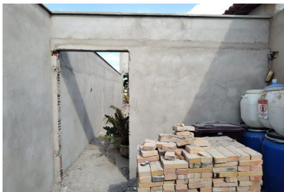
REBOCO C/ ARGAMASSA DE CIMENTO E AREIA PENEIRADA, TRAÇO 1:6
