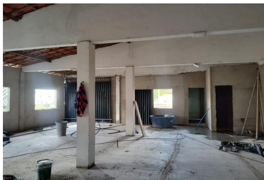
LASTRO DE CONCRETO REGULARIZADO ESP.= 5CM
