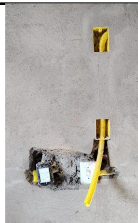
PONTO ELÉTRICO, MATERIAL E EXECUÇÃO
